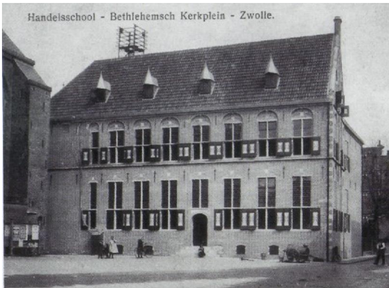
Na de renovatie .. 1922
